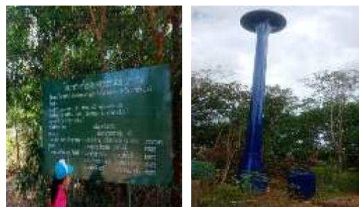
โครงการปรับปรุงซ่อมแซมระบบประปา ม.6
