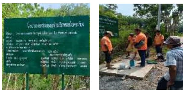
โครงการขุดเจาะบ่อบาดาล ม.2
