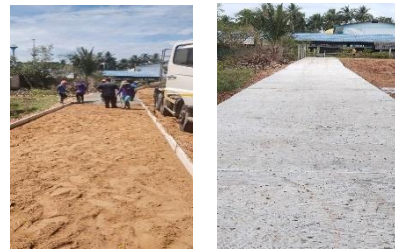
โครงการก่อสร้างถนนคอนกรีตเสริมเหล็กเข้าสนามฟุตบอล หมู่ที่ ๓ บ้านมดตะนอย
