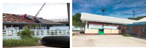
ซ่อมแซมโรงอาหารและอาคารเรียน ศูนย์พัฒนาเด็กเล็ก บ้านมดตะนอย หมู่ที่ ๓
