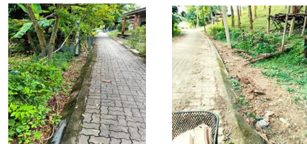
โครงการปรับปรุงท่อส่งน้ำภายในหมู่บ้าน บ้าน หลังเขา ม.๕
