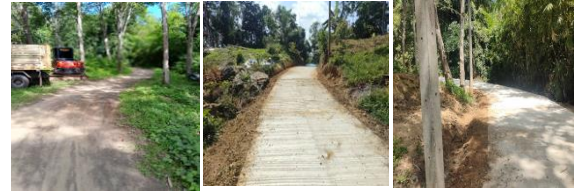
โครงการก่อสร้างถนนคอนกรีตเสริมเหล็กพร้อมไหล่ทาง สายท่าเรือเขาตุเฒ่า ช่วงที่ ๒ ม. ๔ บ้านบาตูปูเต๊ะ
