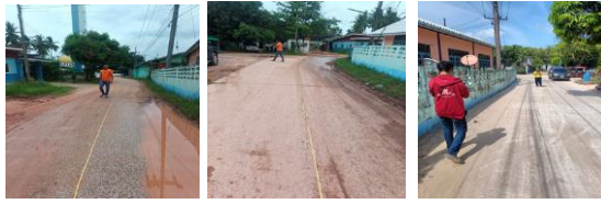
จ้างซ่อมแซมถนนคอนกรีตเสริมเหล็ก ภายในหมู่บ้าน ม.๓
