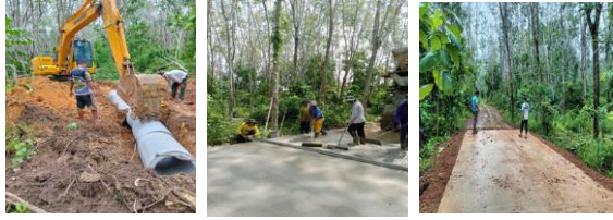
โครงการก่อสร้างถนนคอนกรีตเสริมเหล็ก สาย เปรมปิยะ ฐิติกุลอุทิศ บ้านโคกสะท้อน ม.๑
