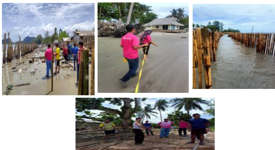
โครงการก่อสร้างผนังกันคลื่น บ้านมดตะนอย ม.๓
