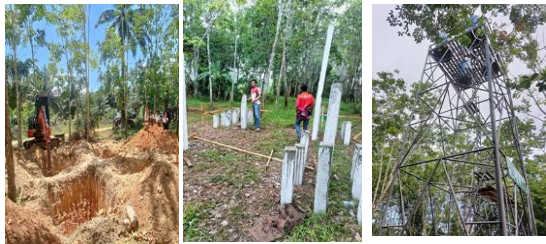
โครงการก่อสร้างห้องพร้อมขยายเขตประปา บ้านสุโขงบาดู ม.๘
