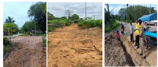
โครงการปรับปรุงท่อส่งน้ำ บ้านสุโหงบาต ม.๘- บ้านมดตะนอย ม.๓
