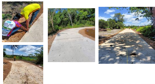
โครงการก่อสร้างถนนคอนกรีตเสริมเหล็ก สายกุโบร์ สายท่ายะหมาด ช่วงที่ ๒ ม. ๘
