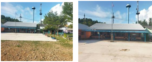
โครงการเทพื้นคอนกรีตเสริมเหล็กสนามเด็กเล่นบริเวณ ศูนย์พัฒนาเด็กเล็กบ้านมดตะนอย หมู่ที่ ๓
